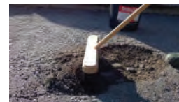
01 Varrer Varrer detritos e lamas para fora do buraco.
