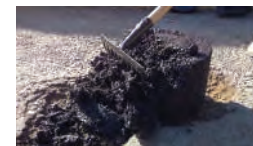
02 Espalhar Espalhar uniformemente o material em camadas de 5cm.
