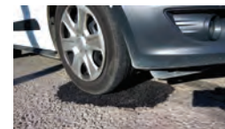
04 Circular Após tapar a área, varrer restos do material à volta para dentro do buraco para finalizar e abrir ao trânsito.
